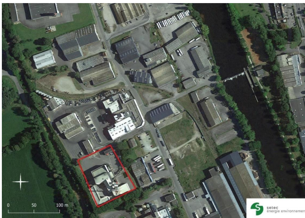
Figure 1 : Site industriel actuel de l'UVE de Le Sourn, sur lequel la deuxième ligne de valorisation serait installée (source : setec énergie environnement – août 2022)
