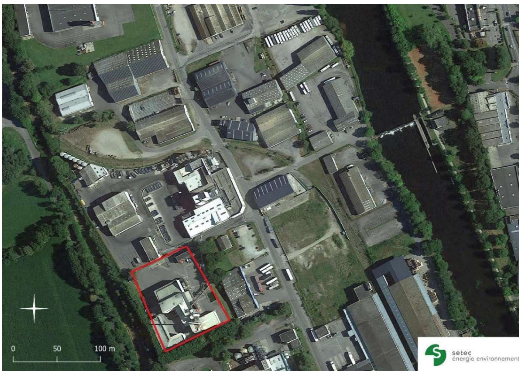
Figure 7 : Site industriel actuel de l'UVE de Le Sourn, sur lequel la deuxième ligne de valorisation serait installée (source : SETEC énergie environnement – août 2022)
